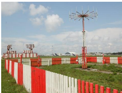
автоматический радиопеленгатор (АРП-95) МВ-ДМВ диапазонов
