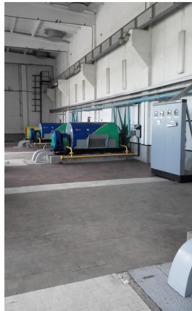
Рис. 2 Машинний зал НПС, в якому встановлені електродвигуни типу
