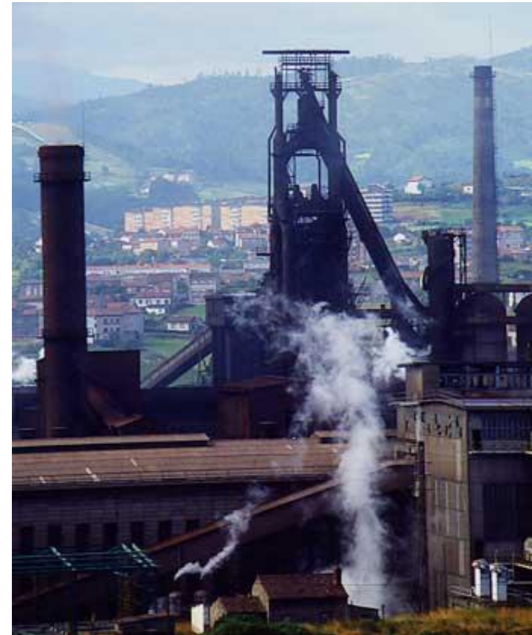
ДОМЕННАЯ ПЕЧЬ в Авилесе (Испания)
