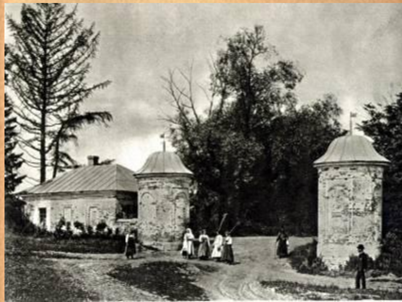
Ясная Поляна. Башни въезда в усадьбу. Фото 1908
