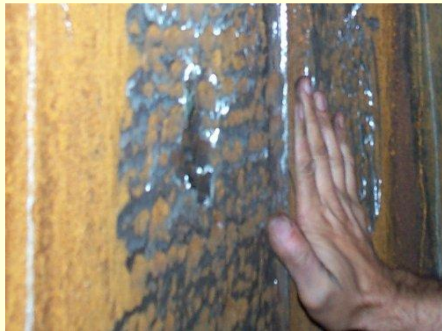
Фрагменты поверхности абсорбера без покрытия
