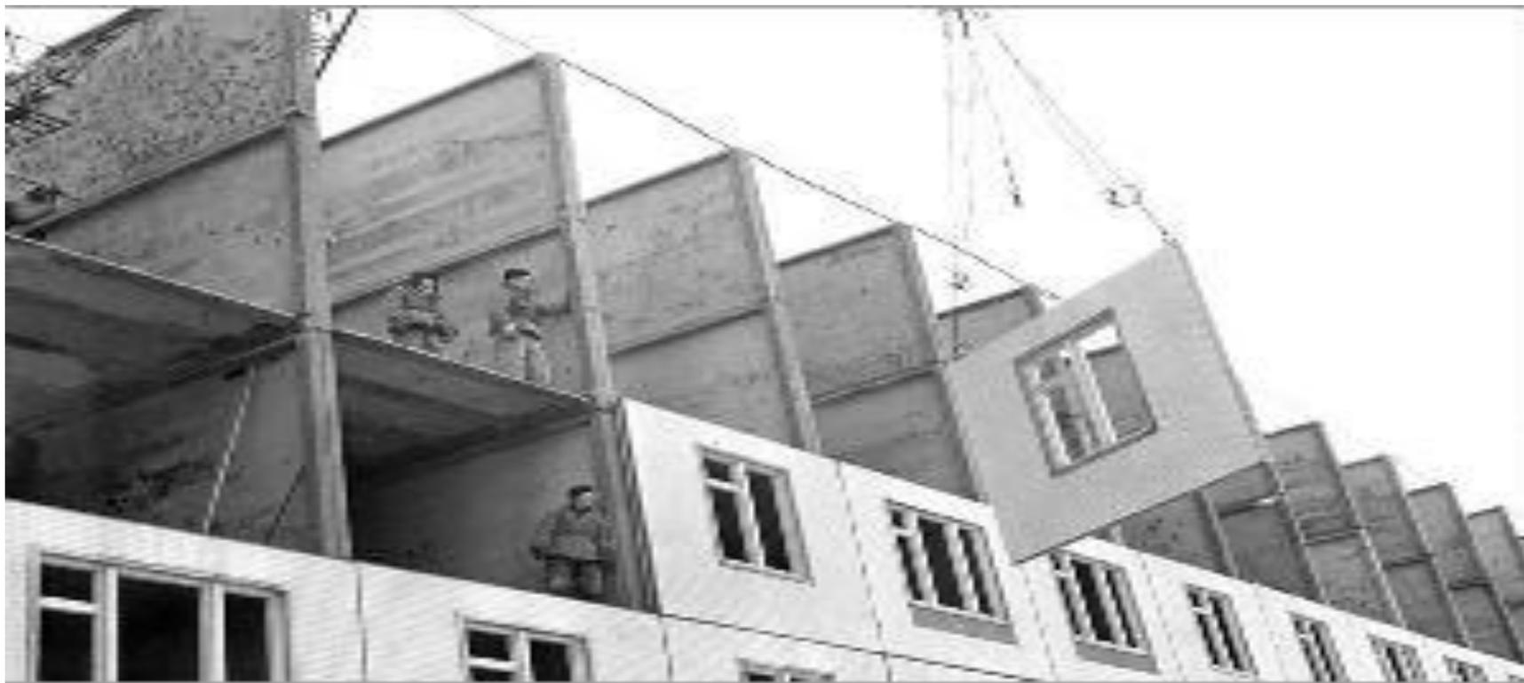
Стыки между блоками тщательно заделывают от проникновения снаружи влаги и потерь тепла изнутри.
