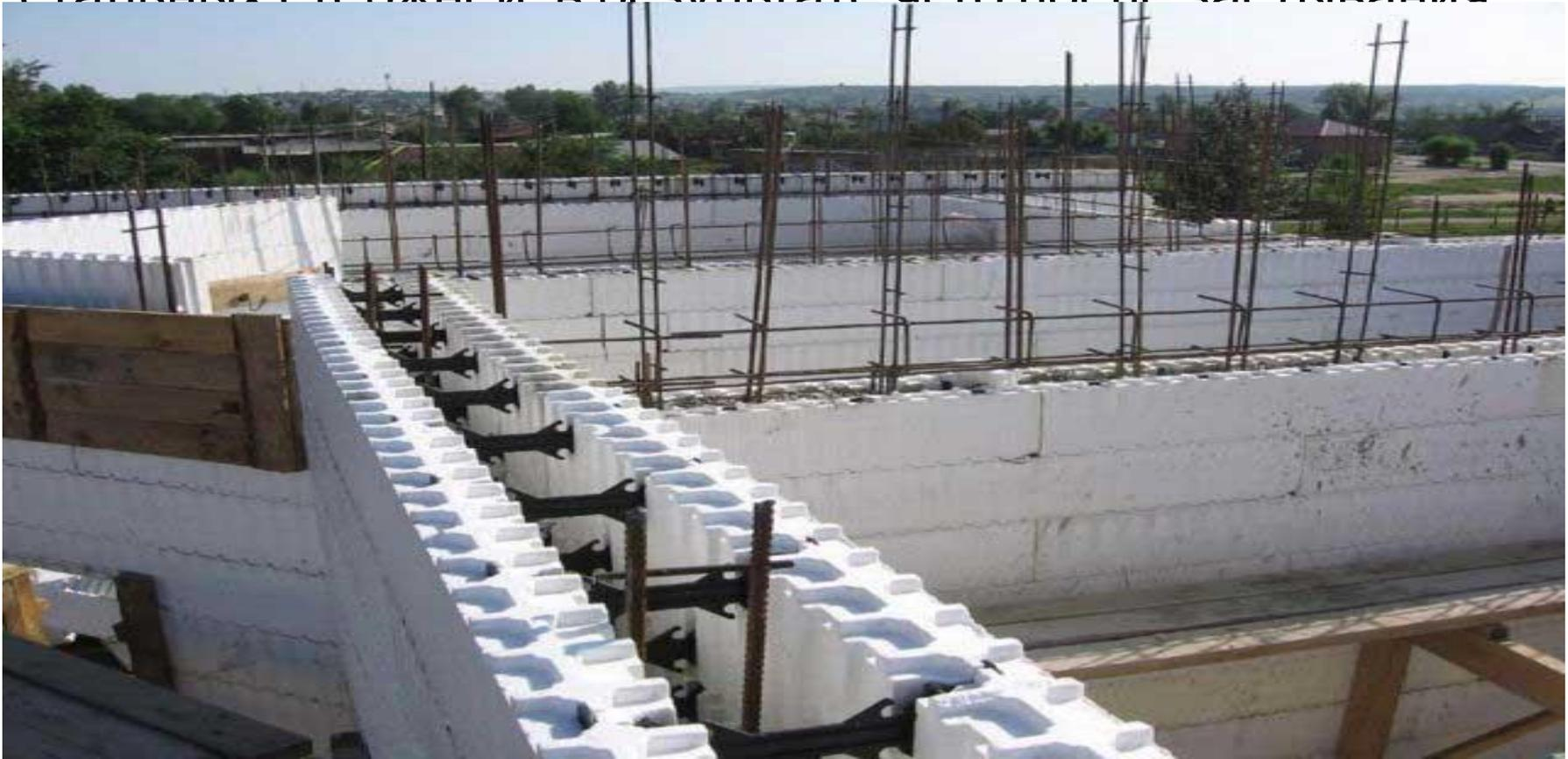
Арматурный каркас получают путем связывания проволокой стальных стержней между собой ( не сваркой) для получения лучшей прочности будущих стен.
