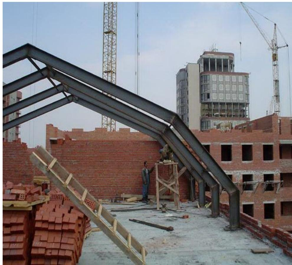
В кирпичных домах стены делают из кирпича, а межэтажные перекрытия - из железобетонных панелей.
