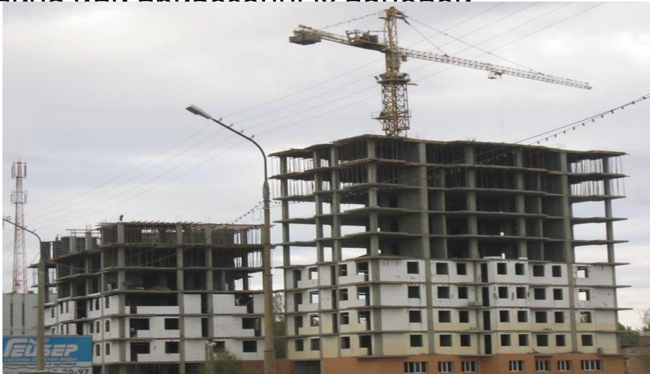
Основной (несущий) каркас выполняется по технологии монолитного строительства.
