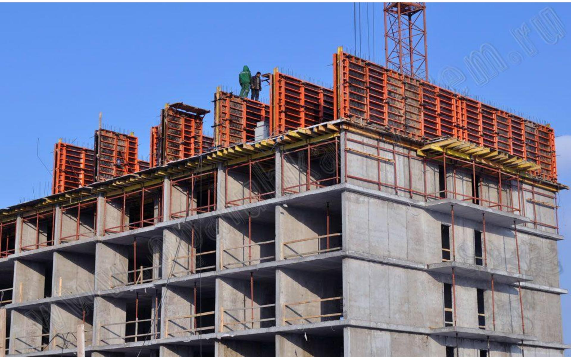
Заливка бетона в стены выполняется либо при помощи подъемного крана,
