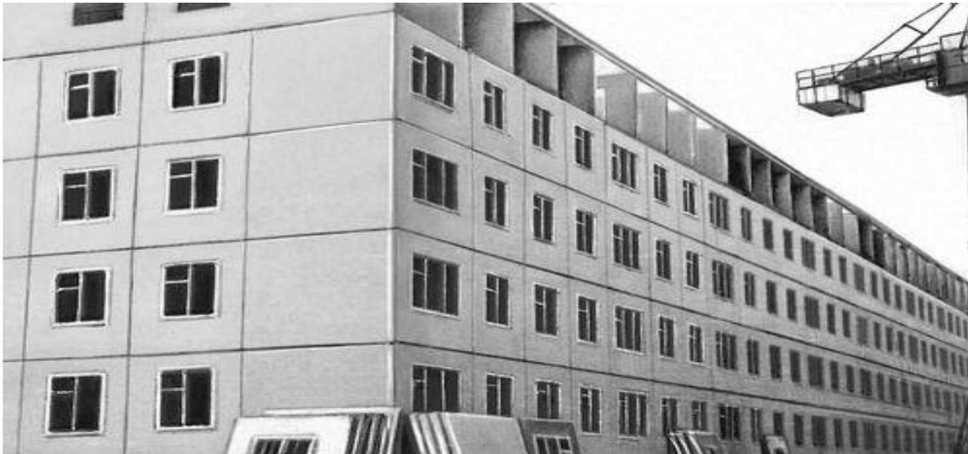
Для установки блоки поднимают подъемным краном и скрепляют с другими блоками при помощи сварки вмонтированных в них **стальных стержней (арматуры)**.
