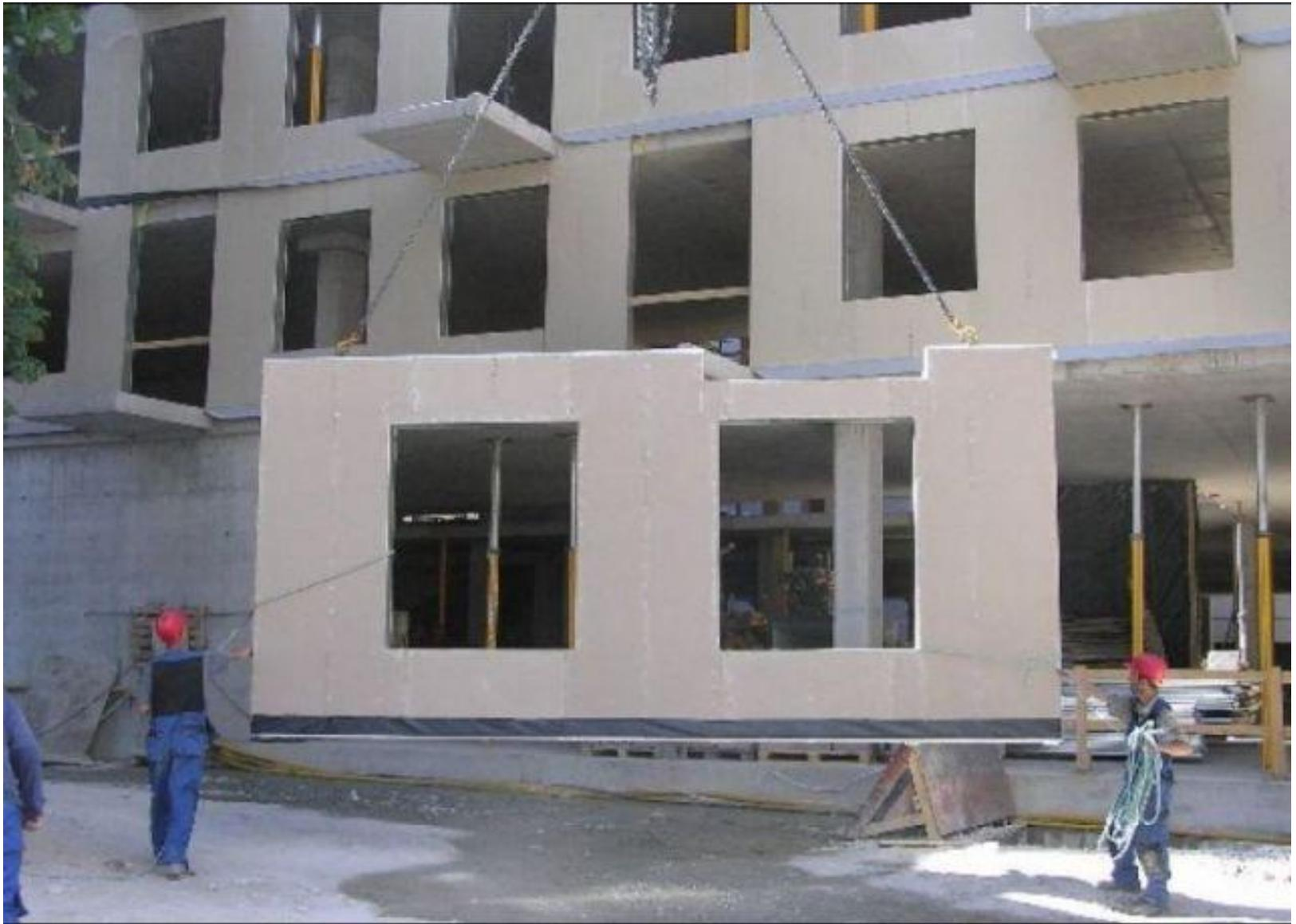
Панели скрепляются между собой при помощи сварки вмонтированных в них стальных стержней (арматуры).
