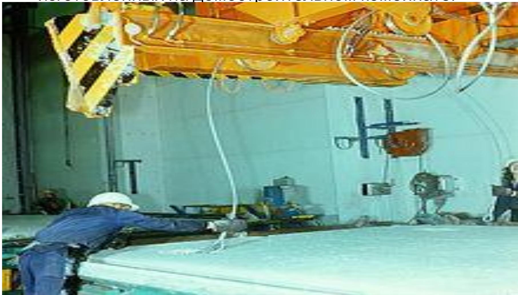
Крупные железобетонные панели привозят к месту строительства дома специальным автотранспортом - панелевозами и поднимают к месту монтажа подъемным краном.
