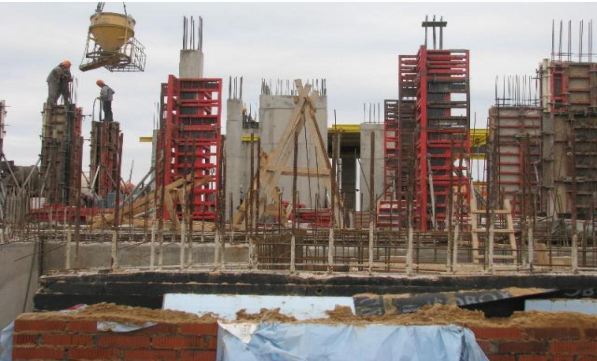
либо при помощи бетоноукладчика, в котором жидкий бетон подается вверх по гибкой трубе.
