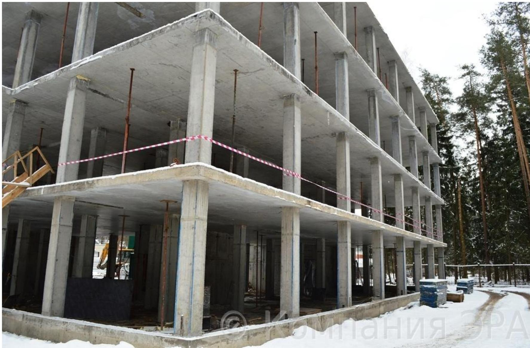
Затем в несущем каркасе монтируются стены из панелей или из кирпича
