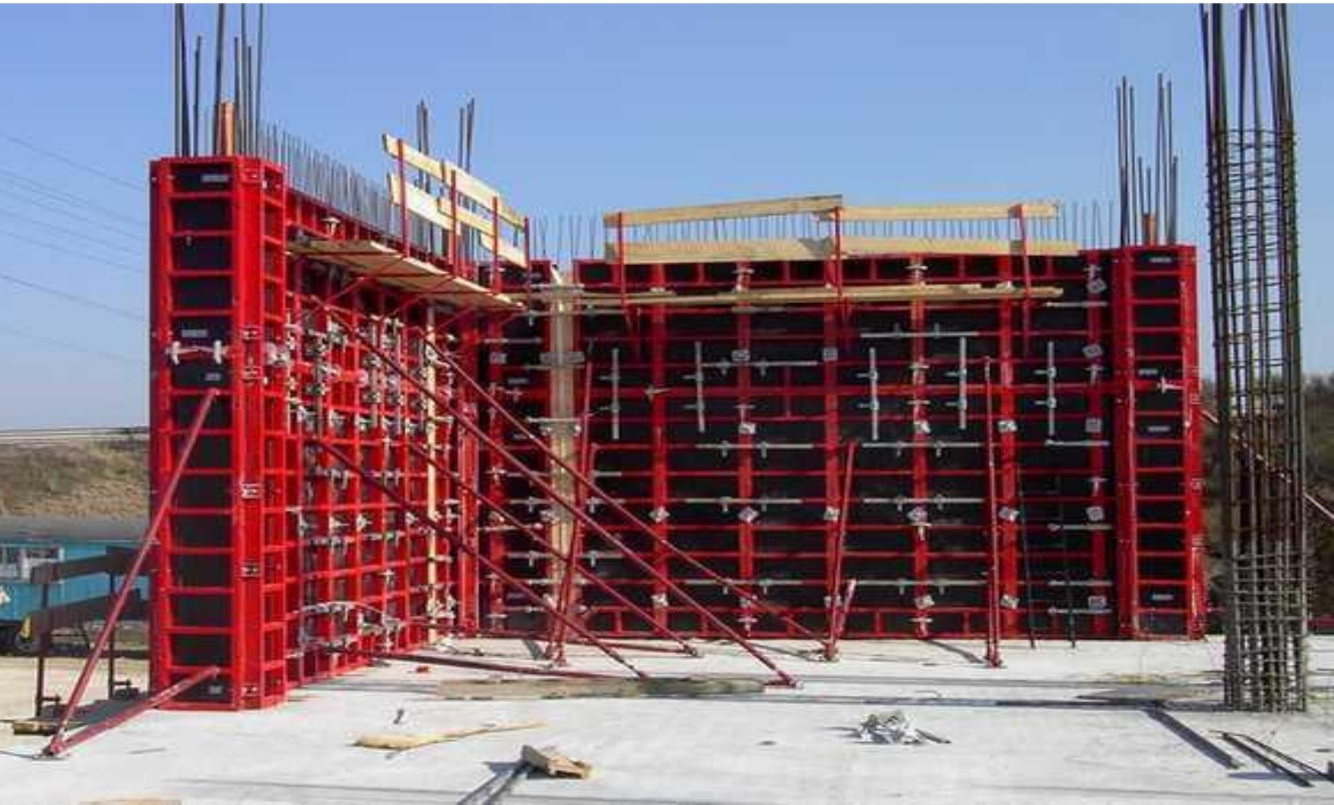
Заливка бетона в стены выполняется поэтажно
