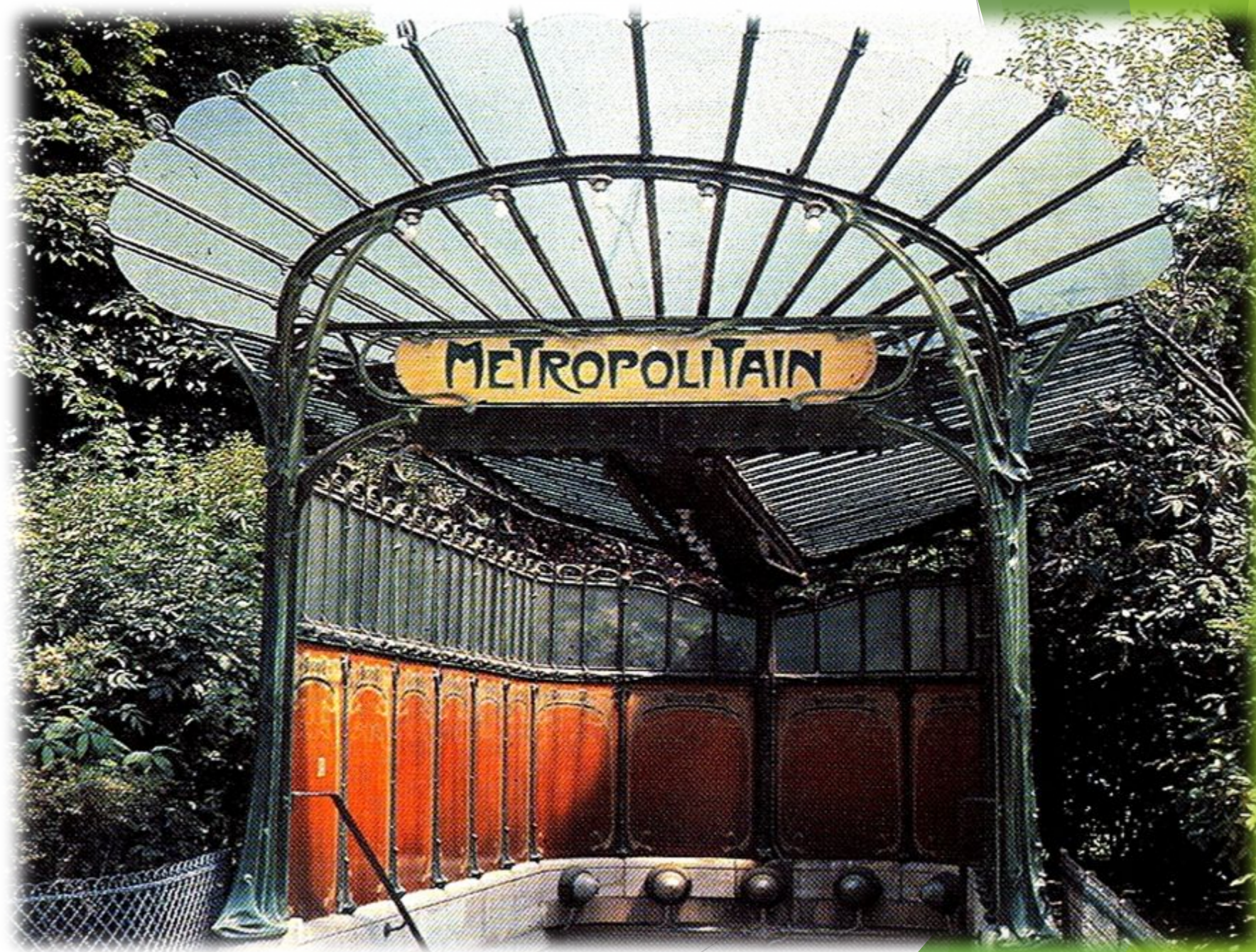
станция метро в Париже, около 1900 г.
