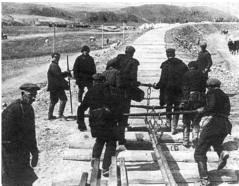
Строительство железной дороги
