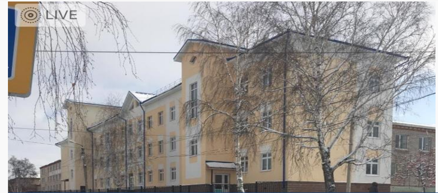
Пристрой к лечебному корпусу с. Языково
