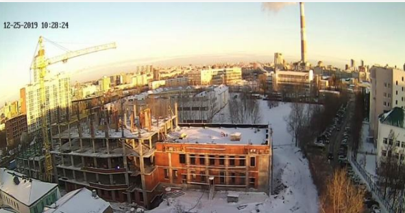
Строительство хирургического корпуса РКЦ
