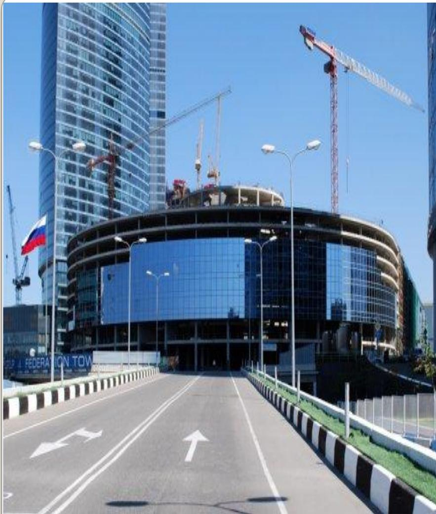
Наиболее технологичным решением являются элементные (блочные) системы, которые предполагают сборку фасада из предварительно изготовленных на производстве кассет. Применение блочных систем позволяет оптимально распределить затраты по проектированию, изготовлению и монтажу, повысить качество выполнения фасада за счет изготовления конструктивно законченных элементов в цеховых условиях. Так был построен рекреационный комплекс с зимним садом и гостиницей в деловом центре «Москва Сити».
