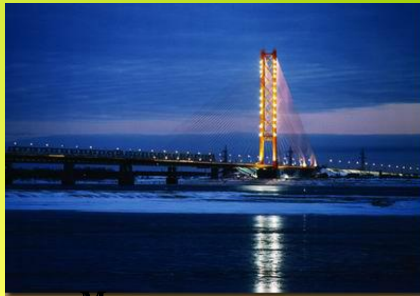
Мост через реку Обь
