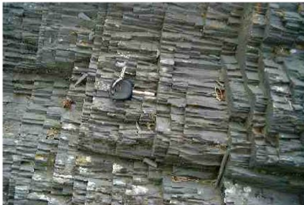
Трещины в сланце, Штайлене, Ослофьорден
