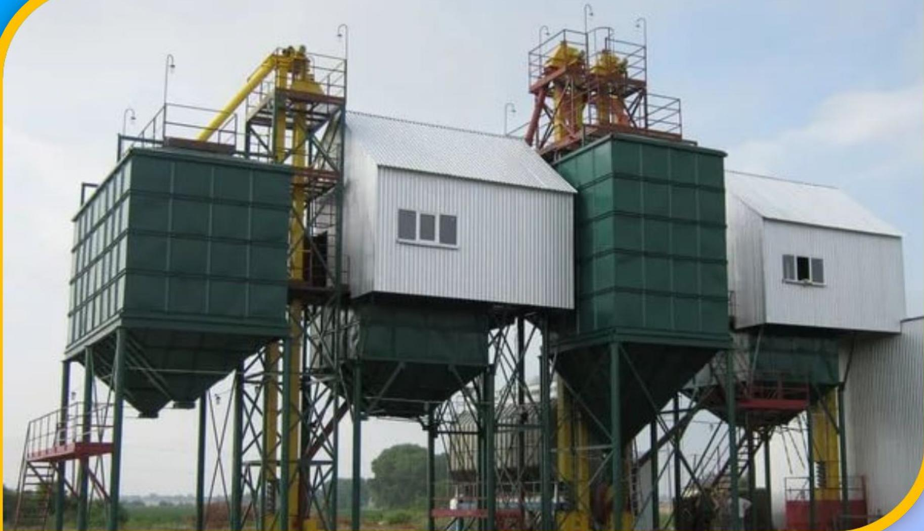
**Элеваторы представляют собой комплекс сооружений, в состав которых могут входить: рабочее здание, силосные корпуса, бункера, устройства для погрузки и выгрузки зерна, зерносушилки и др. Бункерами называют саморазгружающиеся емкости для хранения и перегрузки сыпучих материалов.**
