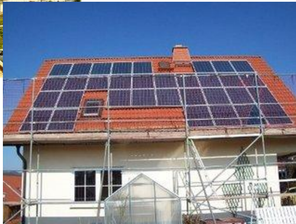
Солнечные панели для выработки электричества из энергии солнца
