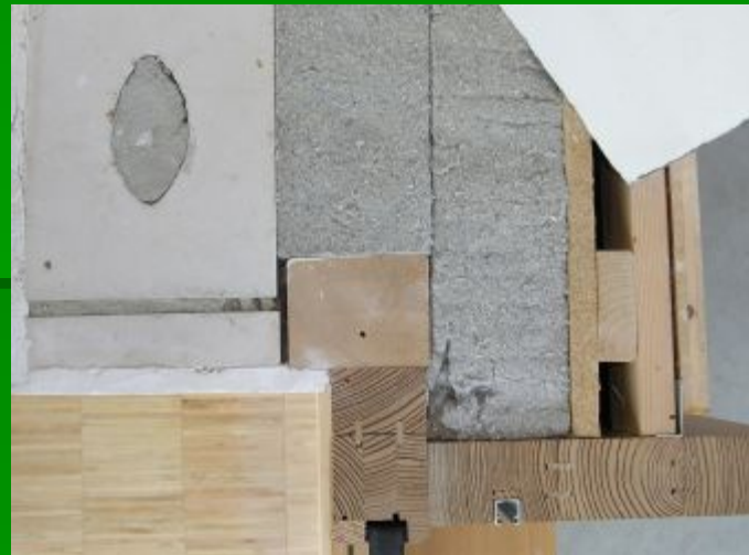
Секционный дом с теплоизоляцией из целлюлозного волокна
