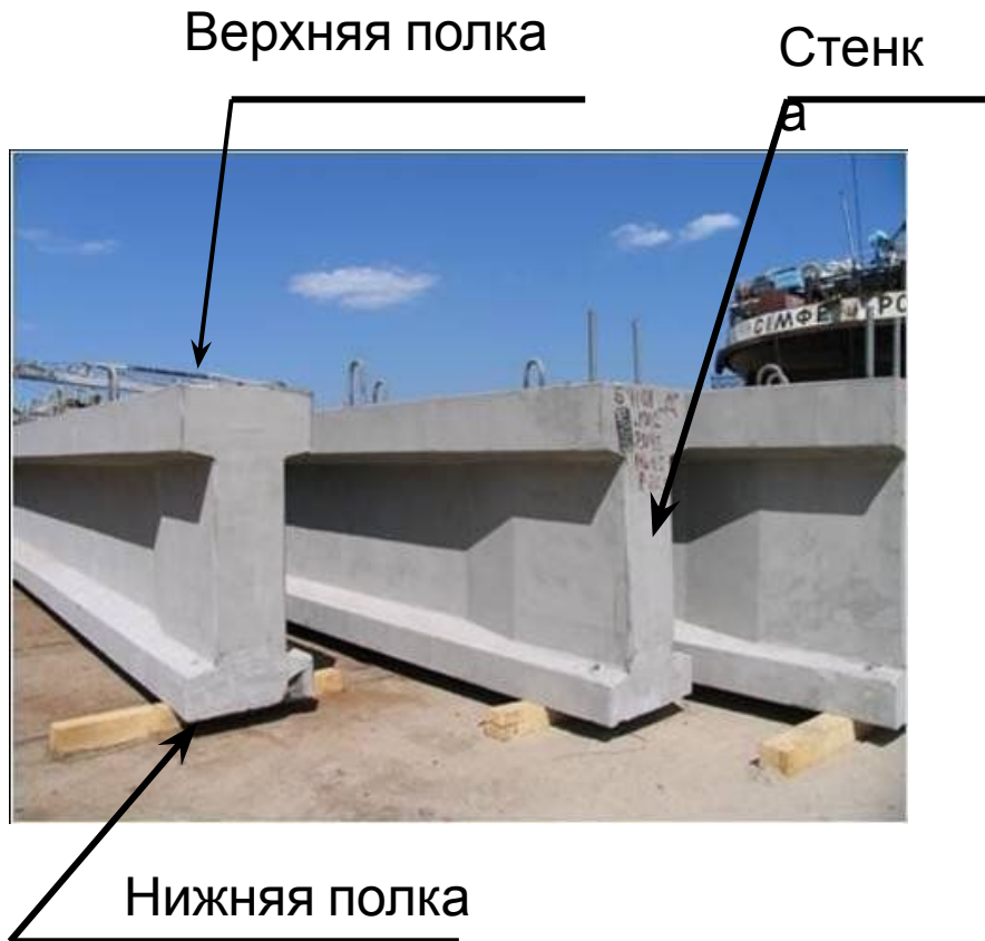
Железобетонная балка с параллельными поясами двутаврового сечения
