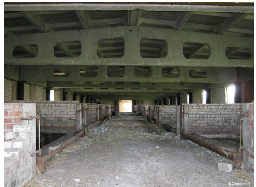
Железобетонная балка с решетчатой стенкой
