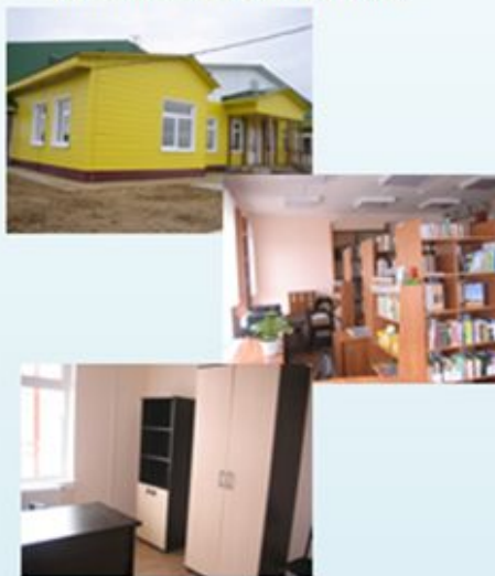
Строительство СКЦ в с. Дон
