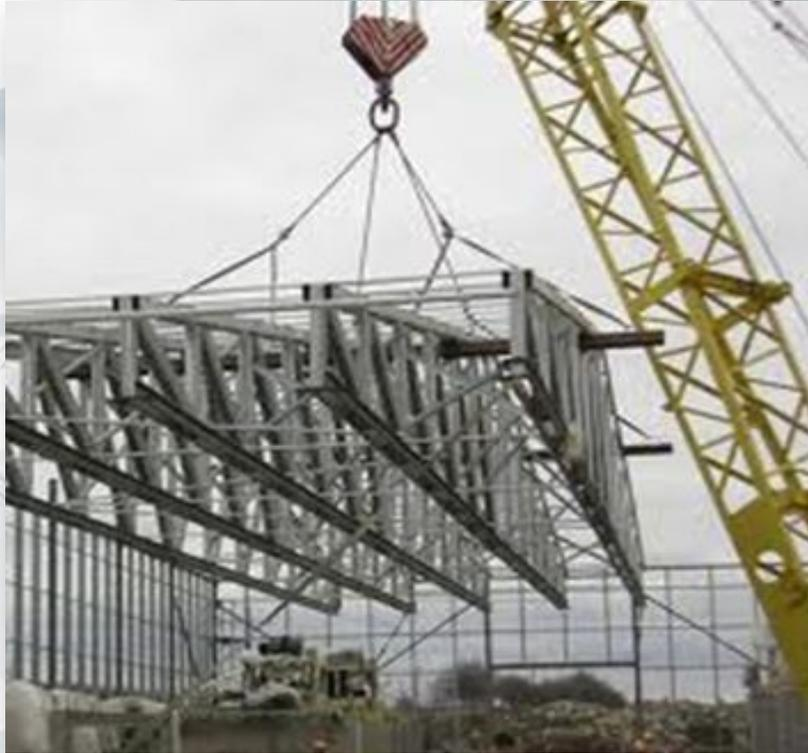
**Металлоконструкции** устанавливают на заранее определенное место, и крюки крана отсоединяют лишь после того, как конструкция выверена и закреплена. Элементы опоры всего сооружения (стойки, колонны) закрепляют анкерными болтами, могут быть установлены временные монтажные связи, балки и распорки, которые убирают после окончания установки.
