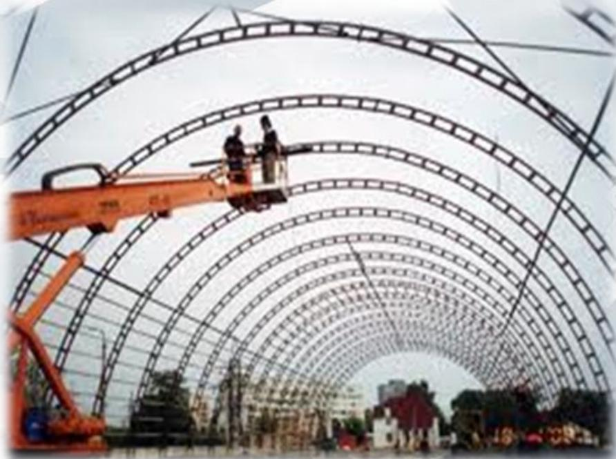
Для того чтобы обеспечить безопасность при работах на большой высоте, сооружаются специальные люльки, площадки, подмости. Это хоть и увеличивает стоимость монтажных работ, но при этом гарантирует полную их безопасность. К подмостям предъявляются следующие требования:
