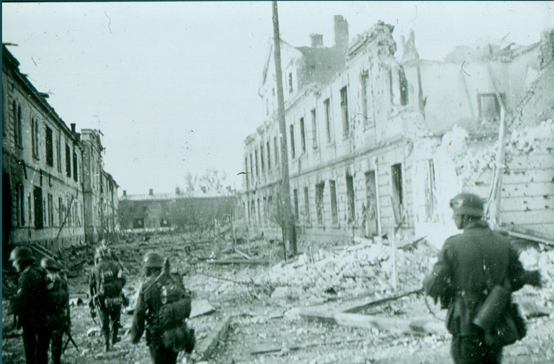
Руины зданий 333 стрелкового полка (справа) и 9 пограничной заставы (слева). Июль 1941 г.
