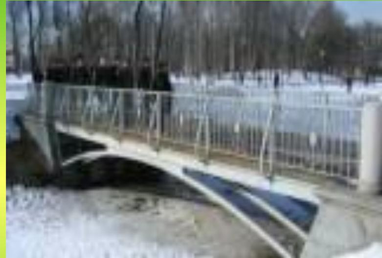
если идти в ногу, то можно попасть в резонанс с мостом, что приведет к его чрезмерному колебанию, а в следствие к его разрушению
