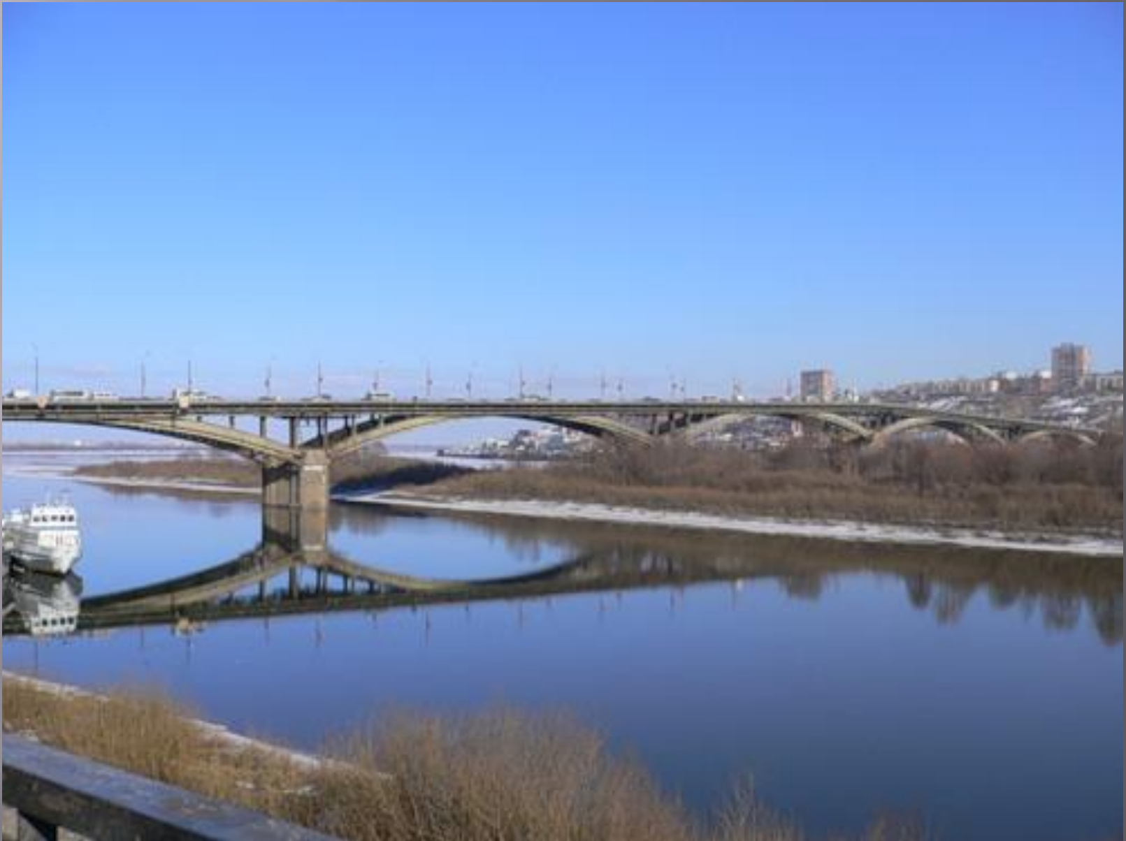
Мост через Волгу и Оку
