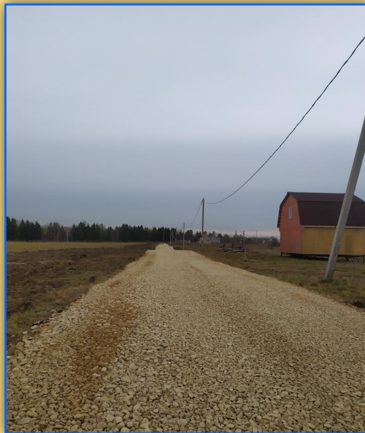
После окончания работ
