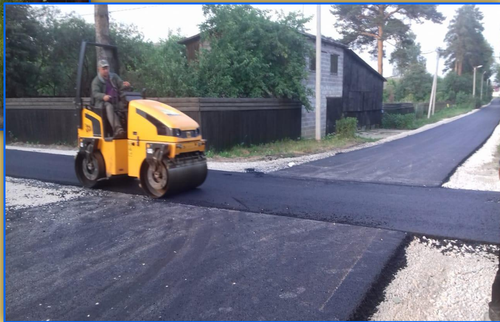
После окончания работ
