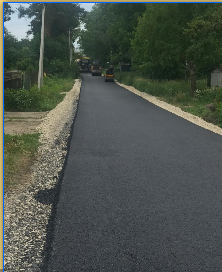
После окончания работ
