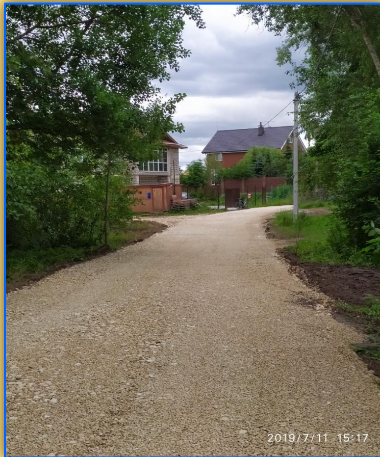
После окончания работ
