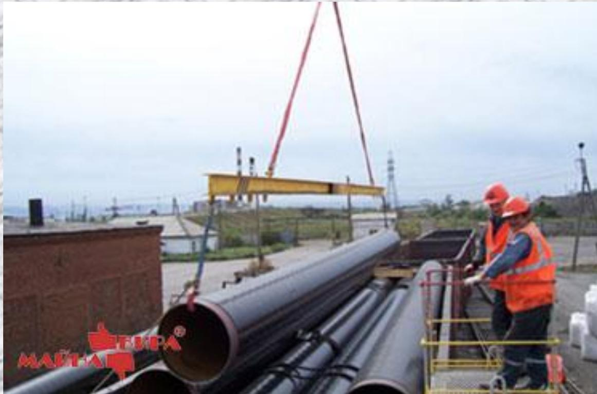
**7.Стропальщик (2) проверяет натяжение стропов.**
