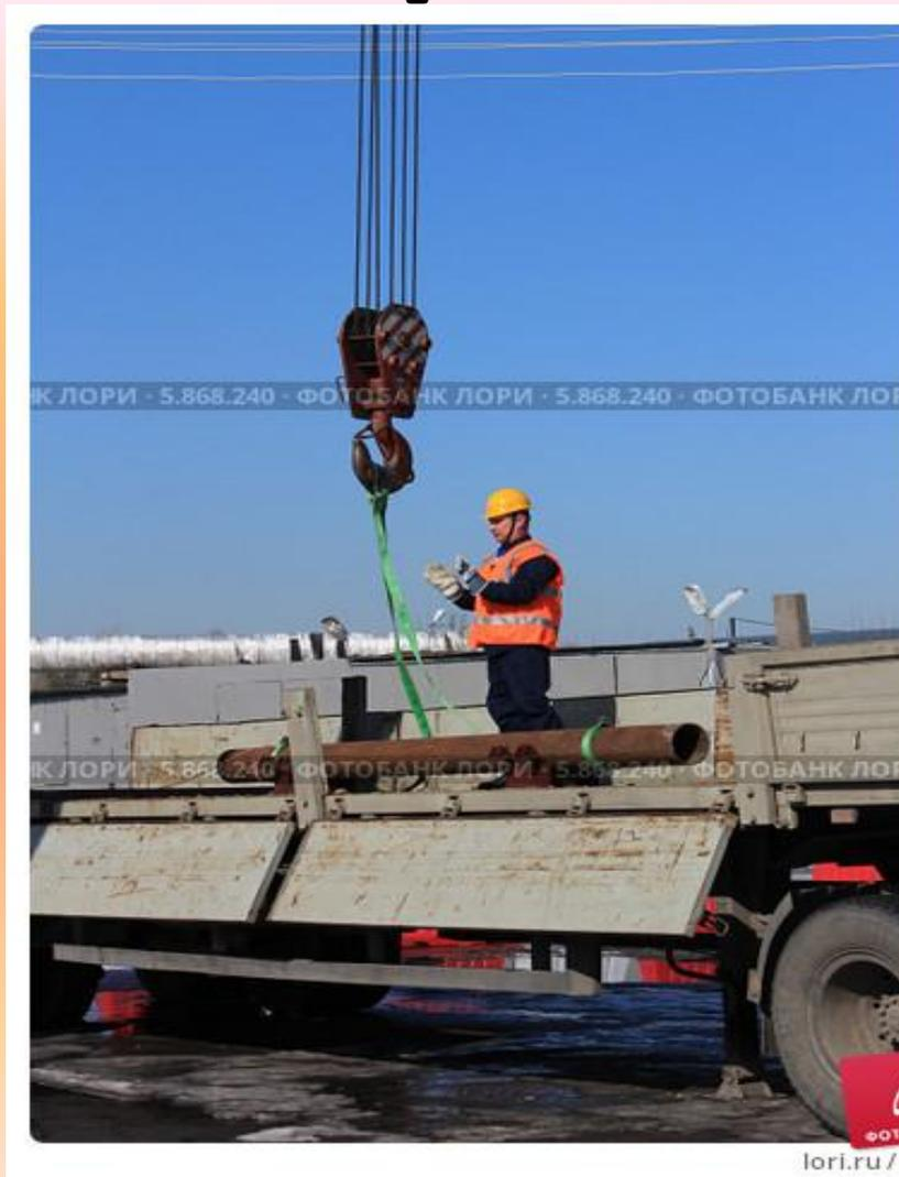
**2.Крановщик подаёт предупредительный сигнал и отпускает крюковую обойму над центром груза**
