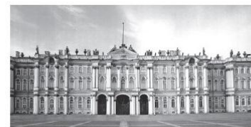
Зимний дворец в Санкт-Петербурге. Архитектор Ф.Б. Растрелли. 1757-1762 гг.
