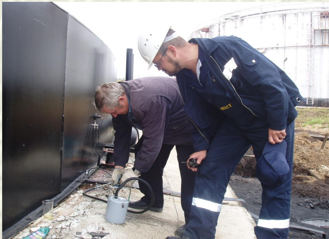
Установка имитатора течи на выступающей окрайке днища РВС.
