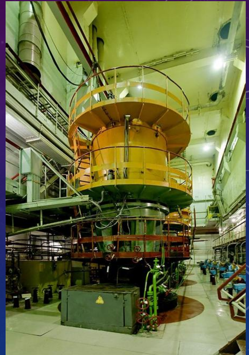
Рисунок. Циркуляционный насос предназначен для циркуляции теплоносителя
