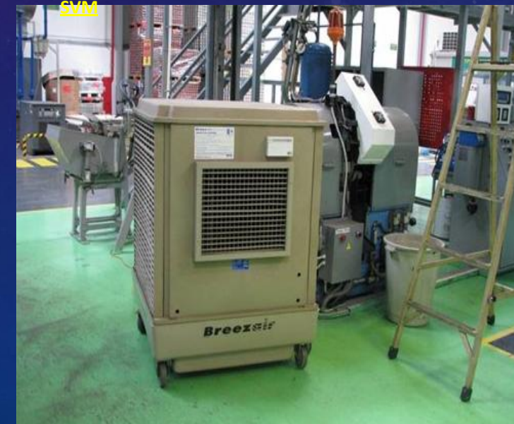
Рисунок. Мобильный промышленный охладитель испарительного типа Breezair EA 120 SVM
