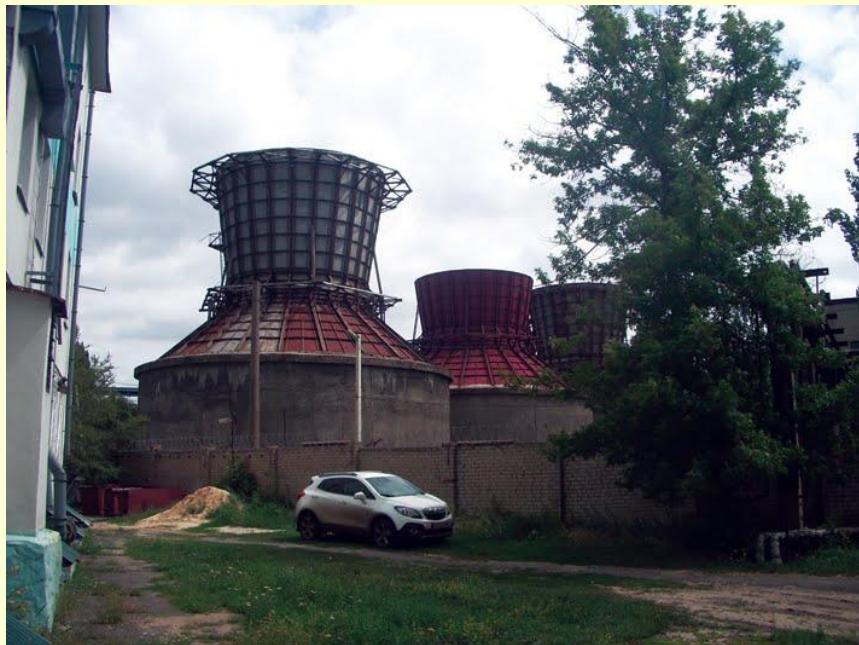
Завод Синтезкаучук (градирня )
