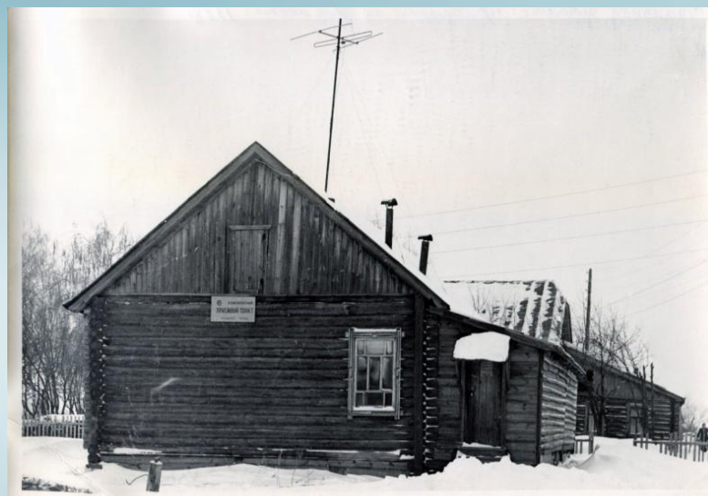
Начальная школа. Год постройки -1968г
