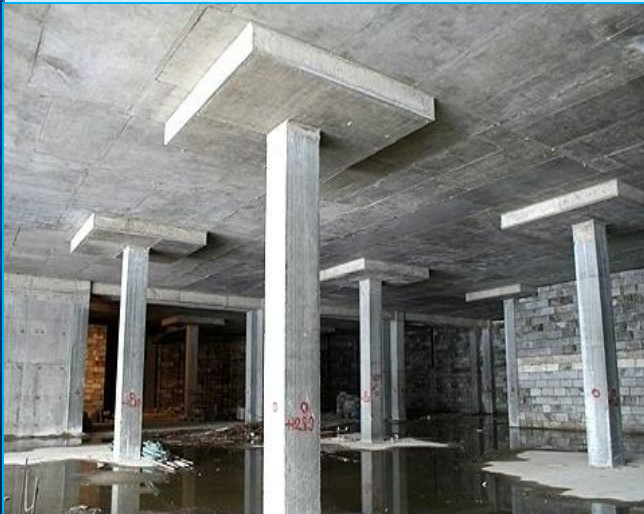
Усиление колонн путем устройства капителей
