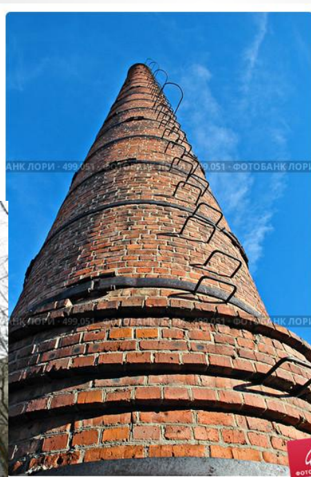
Старая кирпичная труба с металлическими обручами © Ольга Дроздова / фотобанк.лори
