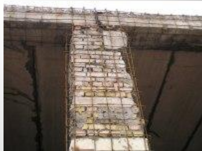
Рис. 3 Устройство железобетонных обоек: а—без увеличения сечения простенка; б—с увеличением сечения простенка
