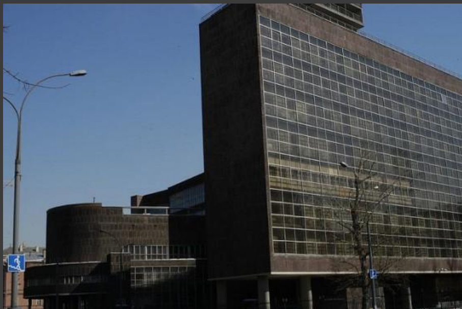
Ле Корбюзье Здание Центрсоюза 1930-е гг. в Москве
