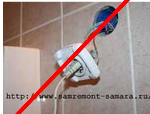
1. Штробы делаются либо горизонтально, либо вертикально. Штробы под произвольным углом (по диагонали) строго запрещены.
