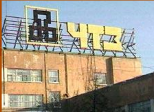
ООО «Челябинский Тракторный Завод»
