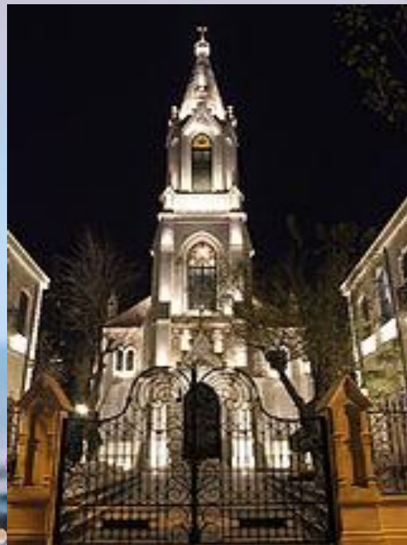
Здание Лютеранской Церкви в Баку.
