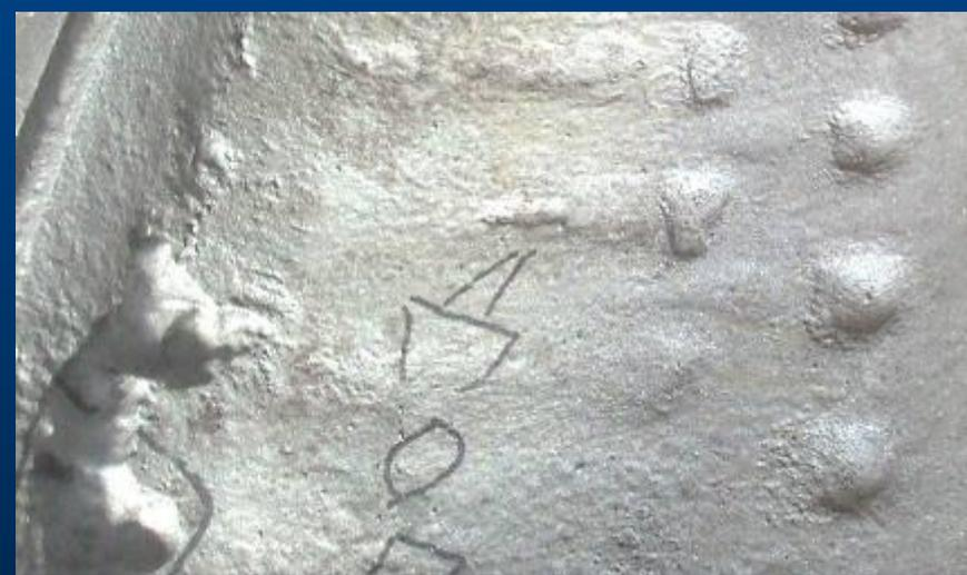
Ремонт крышек произведен подваркой с последующим двухслойным напылением сталей X14H7C3P3 и X28H16M5C1. Через год эксплуатации осмотр состояния покрытия показал, что оно полностью остановило процесс коррозионно-эрозионного износа.
