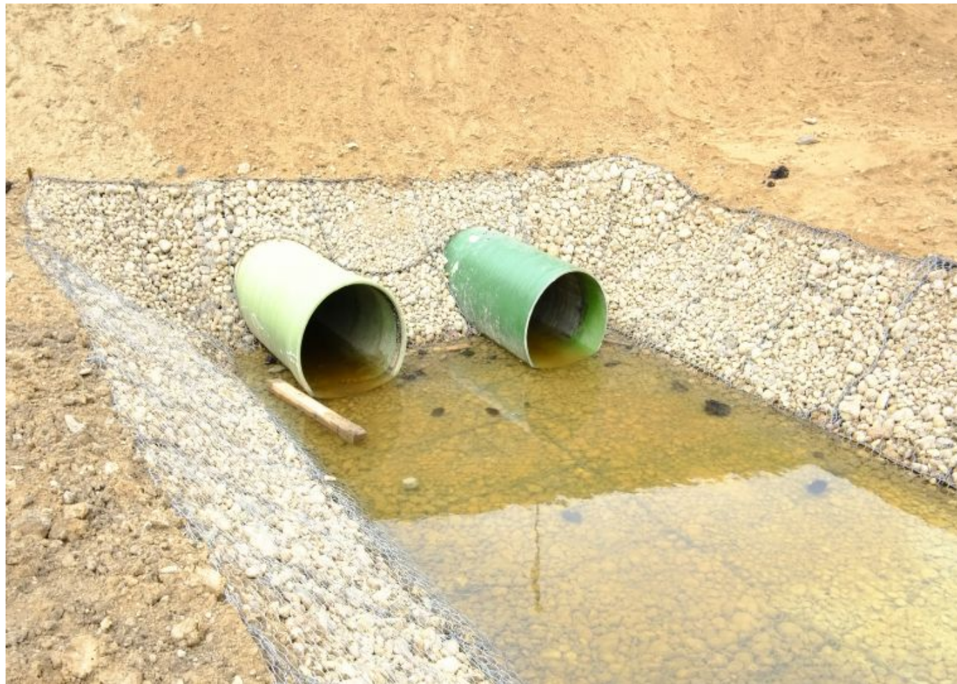
ОБЪЕКТ: М-1 «БЕЛАРУСЬ» КМ 382. ВИД РАБОТ: РЕМОНТ, 2014 ГОД.
