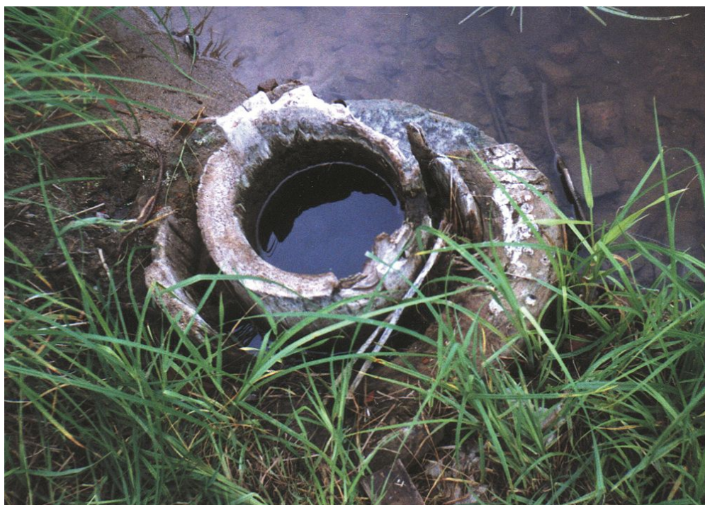
Устье соляной скважины
