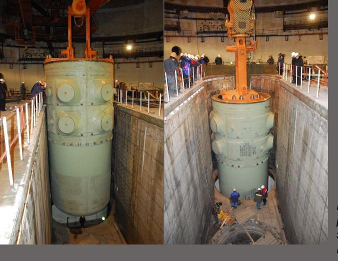
Монтаж корпуса реактора 4-го энергоблока Калининской АЭС
