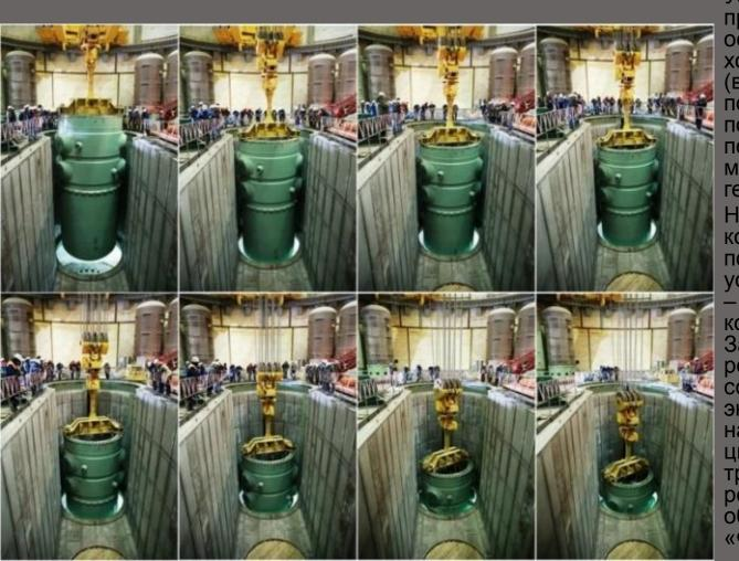
Установка оборудования в проектное положение осуществлялась в два этапа. В ходе первого корпус реактора (вес – более 330 тонн) с помощью крана DEMAG был поднят на транспортный портал на отметку + 26,3 метра и перемещен внутрь гермозоны.
