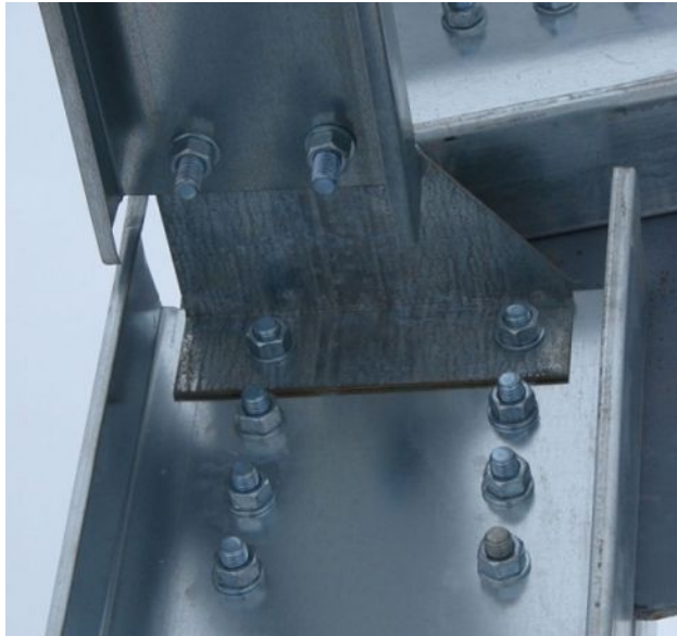
Соединение болтами
