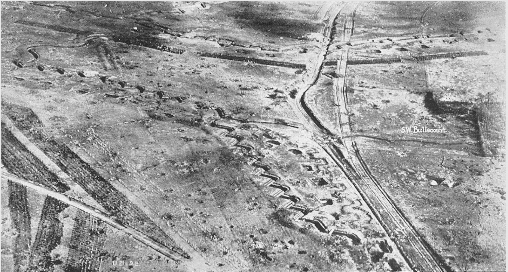
Линия Гинденбурга в районе Буллекурта (вид с воздуха)
