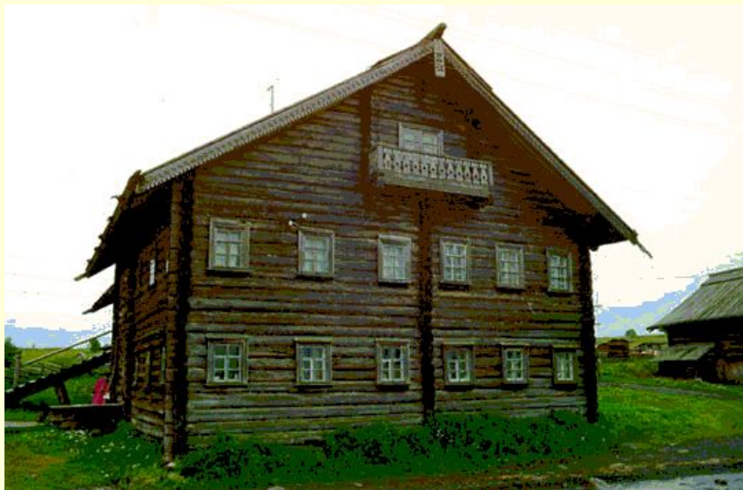
Этот дом был построен в деревне Ямка в Кижях в начале 20 века.
