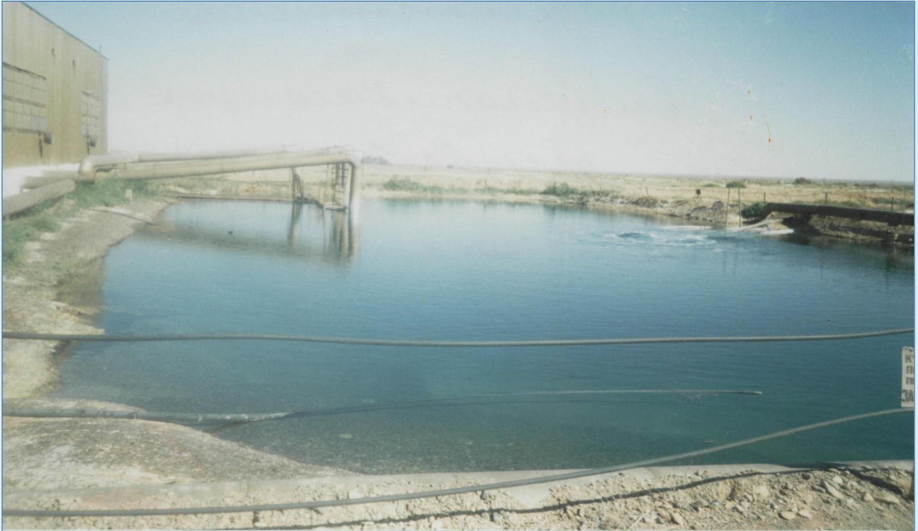
Пескоотстойник выщелачивающих растворов. Добыча урана методом ПСВ.
