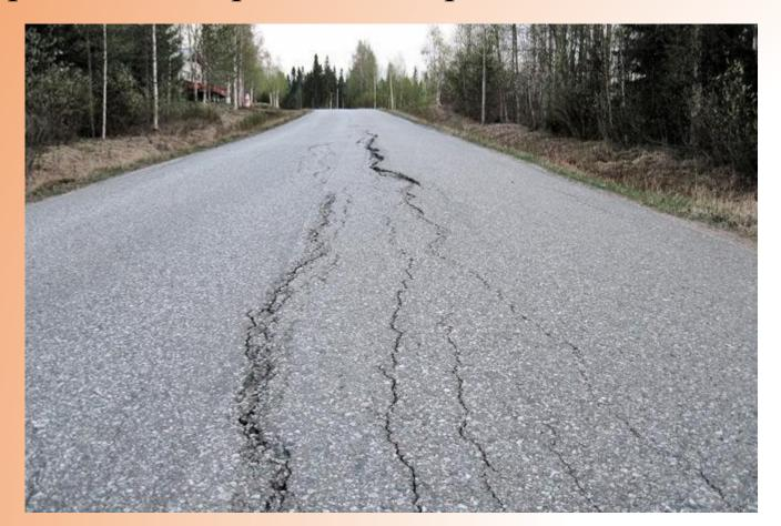
Заделка и ремонт трещин производится, как правило, весной и осенью, когда они имеют значительное раскрытие. Если трещины ремонтируются летом, то ремонт выполняется в утренние часы. В любом случае работы проводятся при сухом покрытии и в сухую погоду при температуре воздуха не ниже +5 °C. Наиболее распространенный способ заделки трещин заключается в заливке их битумом или битумной мастикой.
