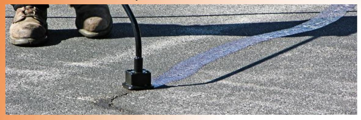
Суть данного способа состоит в том, что очищенную трещину заполняют пластификатором, который размягчает и пластифицирует битум стенок и кромок покрытия.
