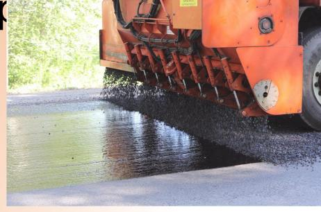
Ремонт трещин поверхностной обработкой в упрощенном виде представляет собой тонкослойное поверхностное асфальтирование и осуществляется путем распределения битумного вяжущего сплошным слоем по поверхности покрытия, последующей россыпью мелкофракционного щебня (4...6 мм) и его укаткой с помощью пневмоколесного
