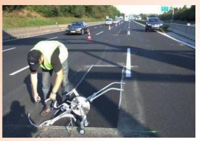
По разлитому битуму укладывается геотекстильная лента, которая после укладки приклеивается к битуму с помощью прижимного валика. После этого трещину заполняют песчаной или мелкозернистой асфальтобетонной смесью, разливая по ней вязкий горячий битум. Далее укладывается верхняя геотекстильная лента шириной превышающей ширину трещины на 6–10 см с каждой стороны.
