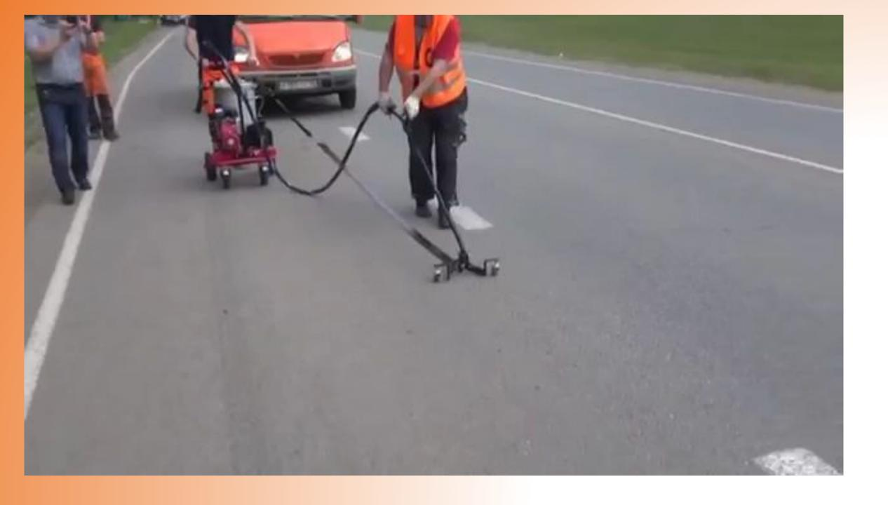
Заделка трещин геотекстильной лентой
