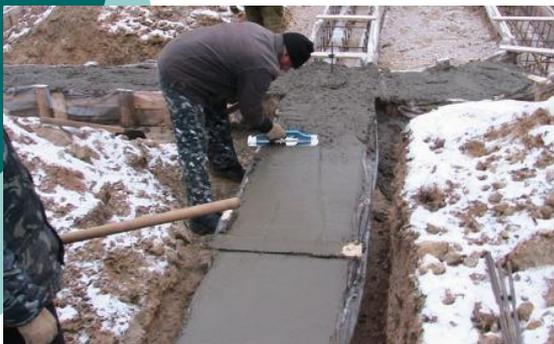
1. Добавки, понижающие температуру замерзания жидкой фазы бетона и принадлежащие к числу либо слабых ускорителей, либо замедлителей схватывания и твердения цемента. К ним относятся некоторые сильные электролиты, такие как нитрит натрия (НН) –  $\text{NaNO}_2$ , хлорид натрия (ХН) –  $\text{NaCl}$ ; слабые электролиты, например водные растворы аммиака; неэлектролиты; вещества органического происхождения, например, многоатомные спирты и карбамид.
