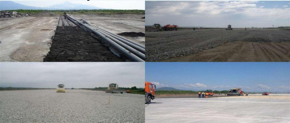
Устройство основания ВПП, нижнего слоя из тощего бетона и верхнего слоя покрытия из марочного бетона, планировка обочины ИВПП
