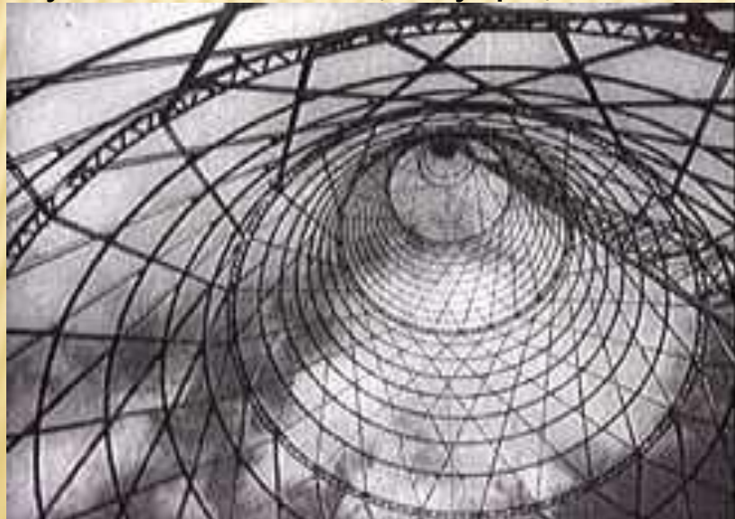
Общий вид металлических конструкций Шуховской башни (изнутри).
