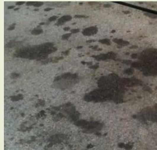
5. Трещины вдоль арматурных стержней с шириной раскрытия до 3 мм. Явные следы коррозии арматуры
