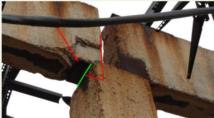
12. Отрыв анкеров от пластин закладных деталей, деформация соединительных элементов, расхождение стыков
