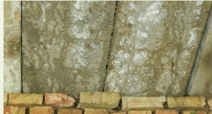
16. Покрытие поверхности сажей и копотью, сколы бетона и обнажение арматуры по углам, обнажение арматурной сетки плоских элементов, отделение бетона без обрушения
