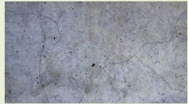
2. Волосные трещины вдоль арматуры, иногда след ржавчины на поверхности бетона
