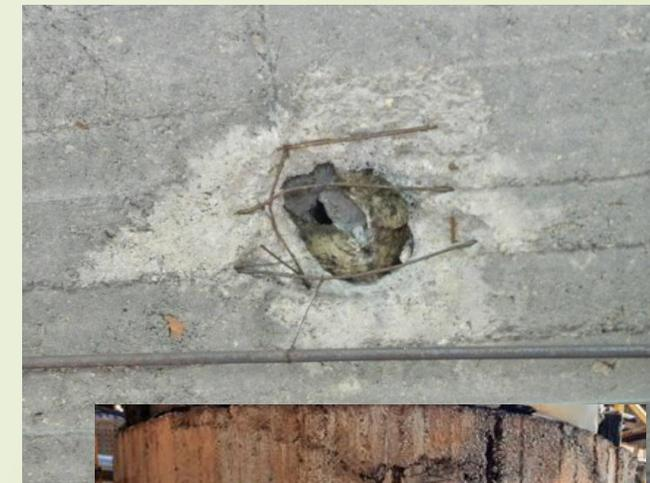
14. Трещины, выбоины, раскалывание фундаментов под оборудование, вырыв анкерных болтов
