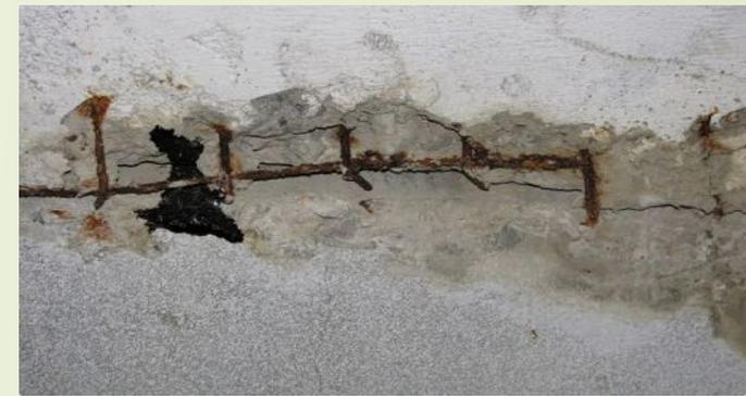
6. Отслоение защитного слоя бетона
