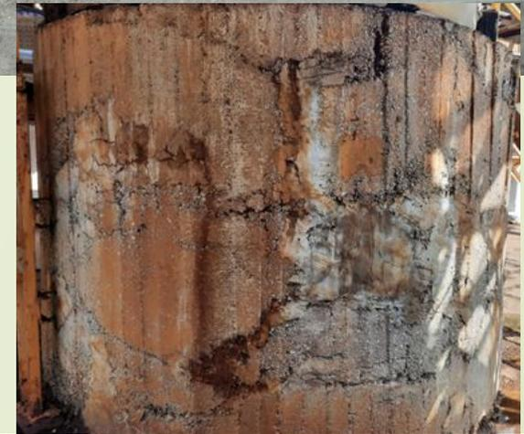
15. Высолы на поверхности бетона
