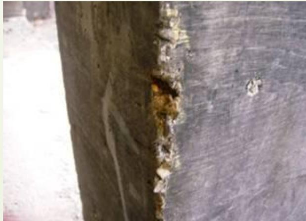
4. Промасливание бетона
