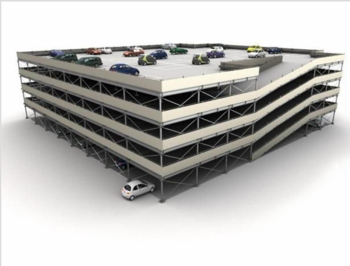
Гаражи с рампами позволяют достигать место стоянки по достаточно короткому пути, надежны в эксплуатации, обслуживаются малочисленным персоналом, обеспечивают быстрый пропуск автомобилей в здание и из него (1 автомобиль каждые 6 сек), но устройство рамп ведет к значительным потерям полезной площади.
