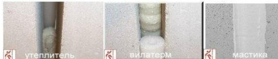
Герметизация стыков в стандартном исполнении проводится по периметру. В среднем длина вертикальных швов составляет 3,5 пог. метра. Длина горизонтального шва в зависимости от серии дома составляет
