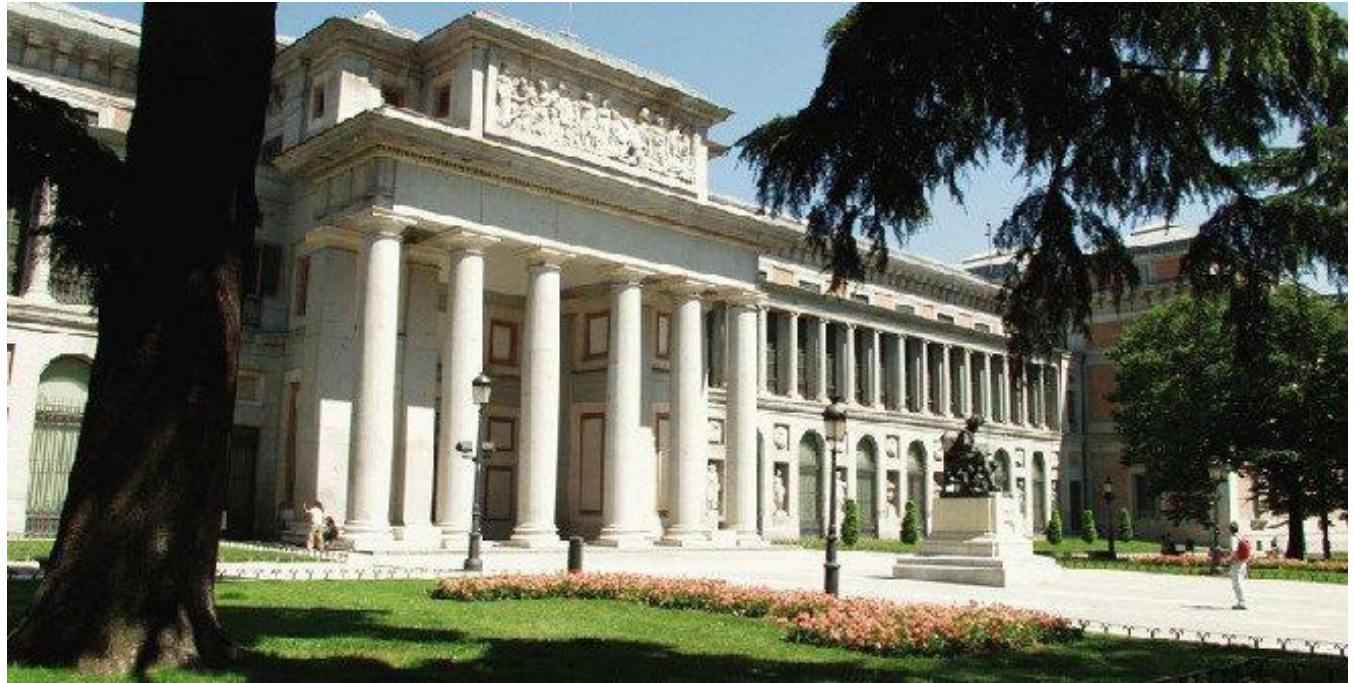
Fachada Paseo del Prado
